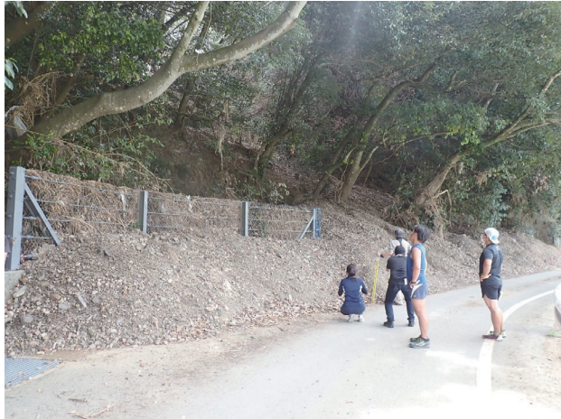
図-7 シカの食害による斜面崩落
