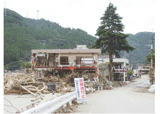
図-3 坂本町中心部の被害
