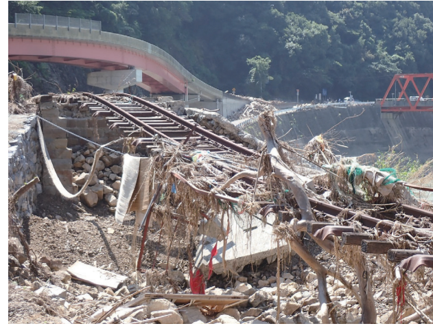
図-2 大きな被害を受けた肥薩線
