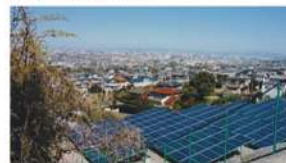
八尾・高安山 住宅群を抜けた西方を望む、ソーラーパネルが当風
