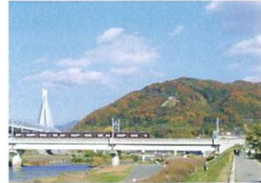
猪名川から見た五月山公園緑地 真ん中右手に豪雨で崩れた斜面が見える
