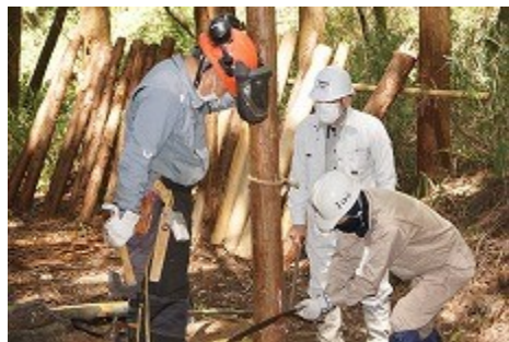
左：ナタで受け口修正 中：ロープにて倒す方向に引っ張る 右：かかり木にならず倒れる
