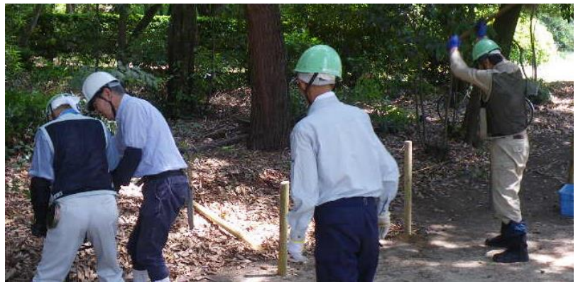
散策路の杭打ち
