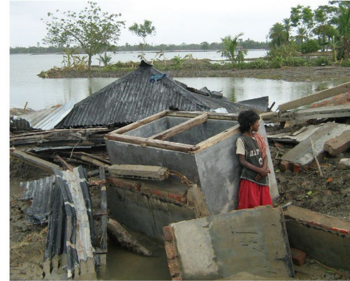
写真-2 バングラデシュ・サイクロンアイラ(2009)による家屋の倒壊
