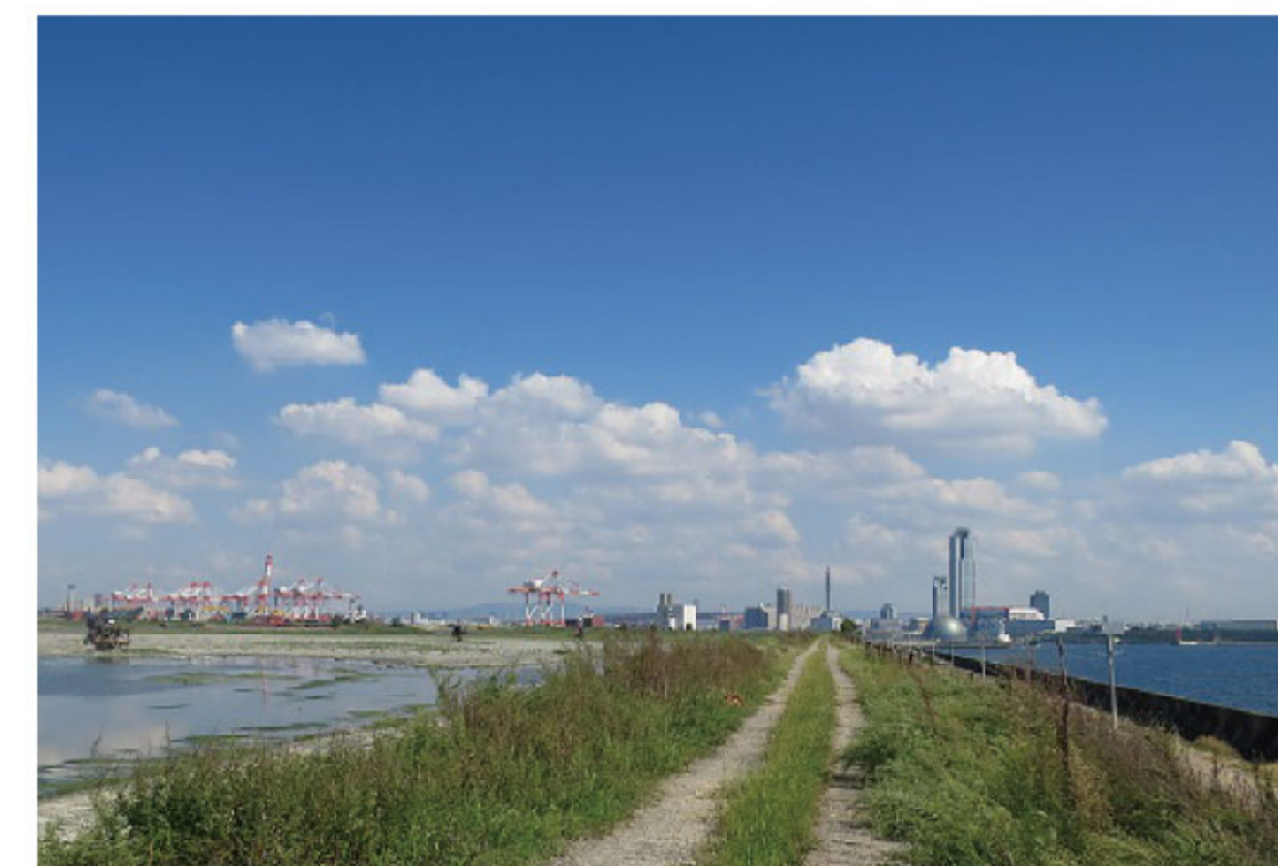
写真-5 夢洲南岸の海岸沿い堤防
