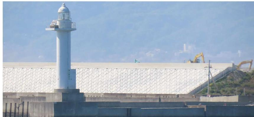
写真-2 築堤にはコンクリートのカバー工事が施工されている。2023年4月22日
