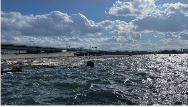
写真-2 埋立計画のある岸和田貯木場
