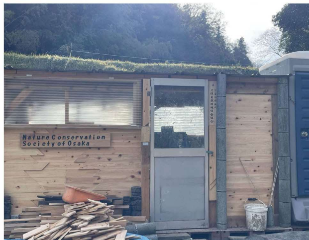
図-4 地権者さんに設置していただいた作業小屋。
