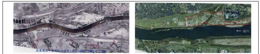
図-5 低水路の拡幅と直線化 (淀川の合流点付近)
